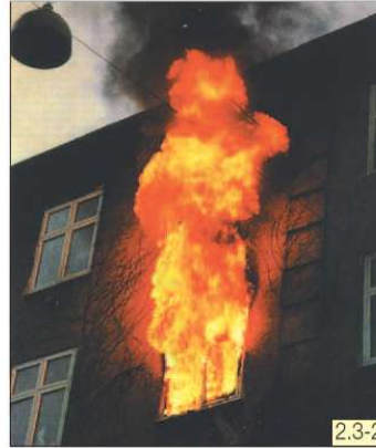
2.3-2 Wohnraumbrand 1994 in Kopenhagen. Die Flammenlängen betragen ca. 4 bis 5 m. Es fand ein Feuerüberschlag ins nächste Geschoss und in das Dach statt.
